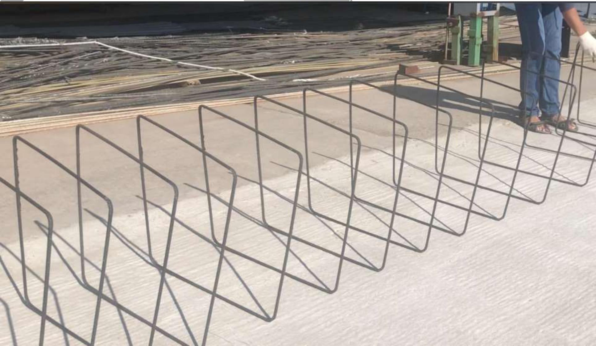
Композитные элементы для каркасов
