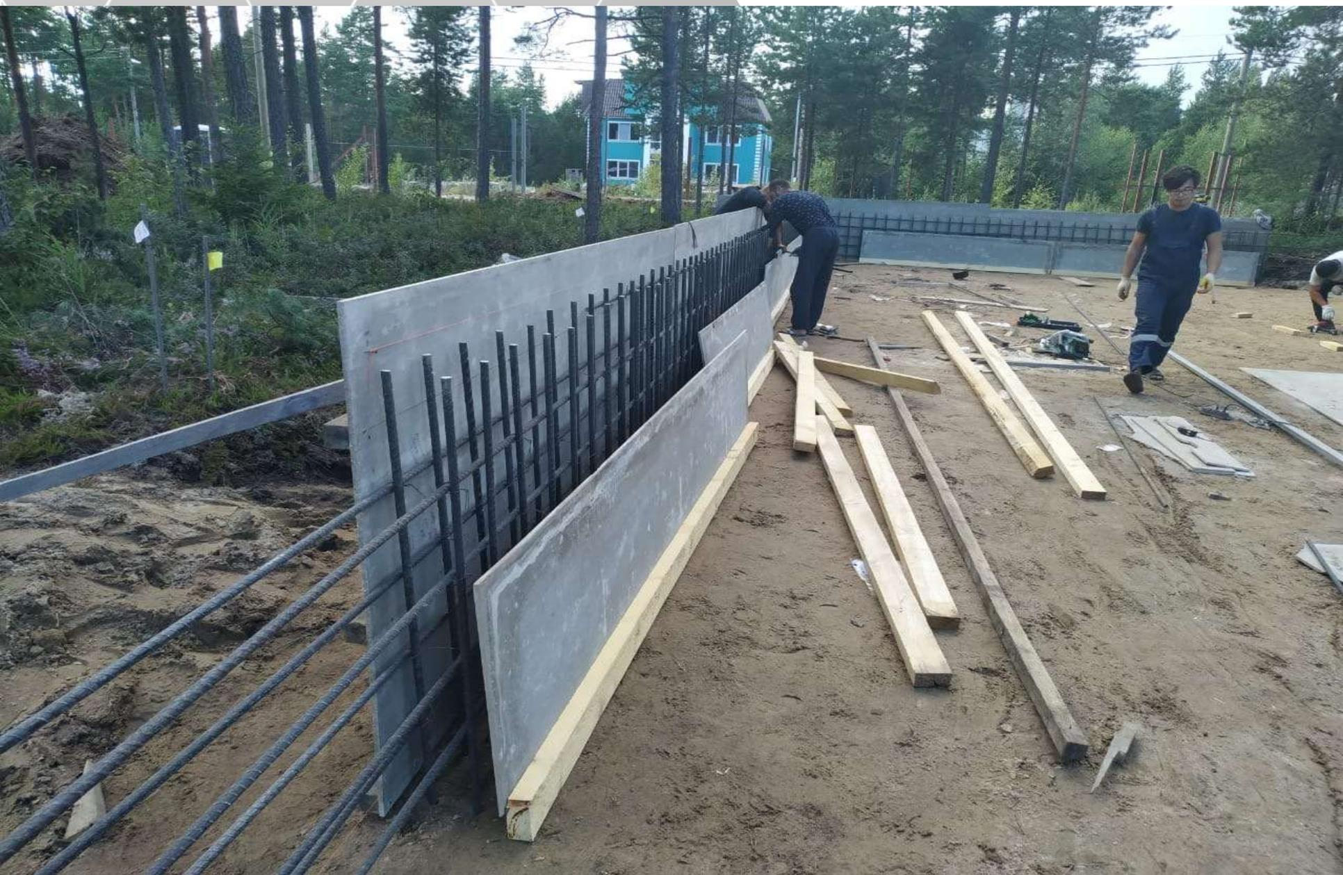
Использование композитной арматуры торговой марки BASIS в строительстве. Фундамент трехэтажного здания.
