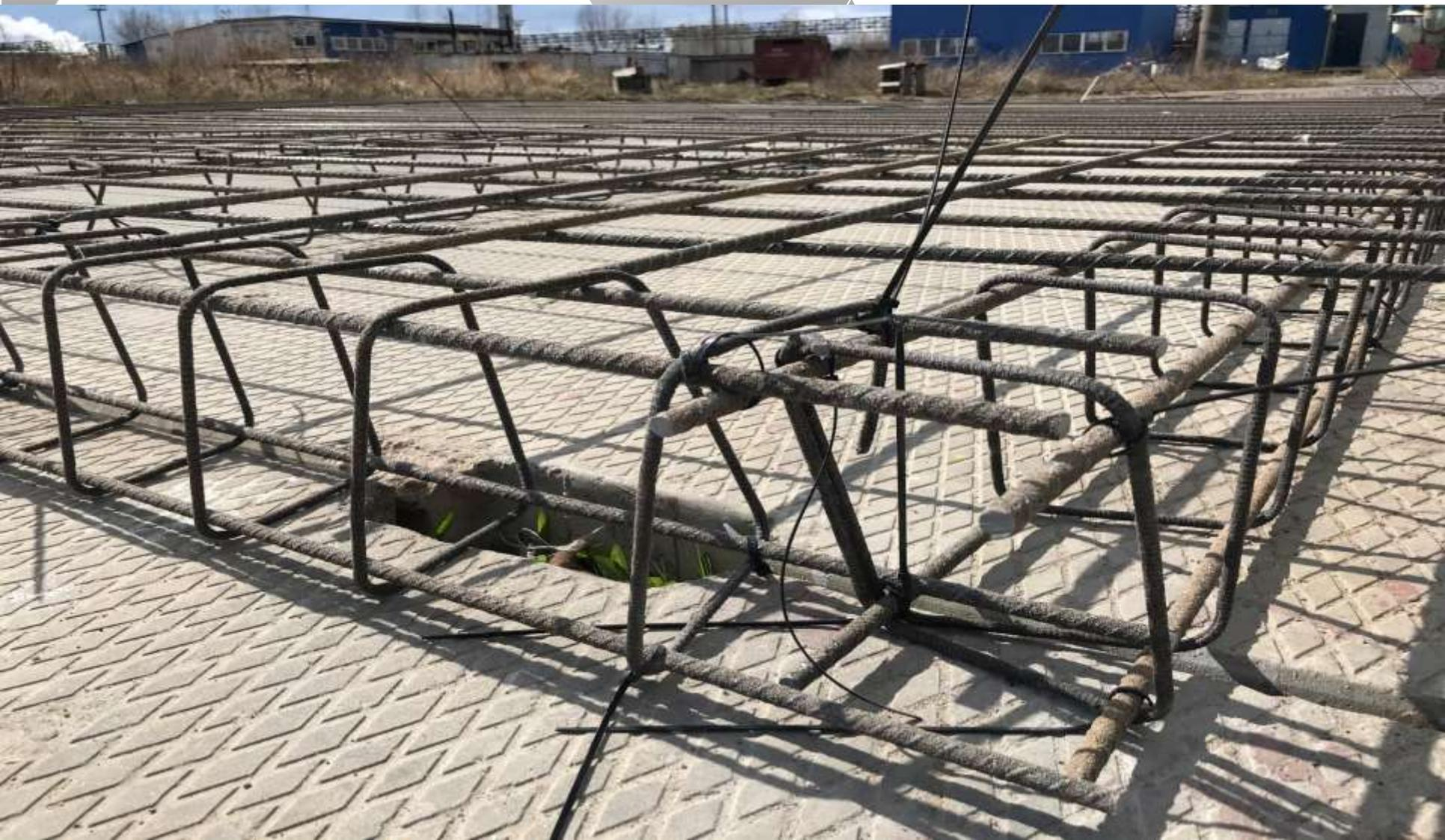
Композитные элементы для каркасов
