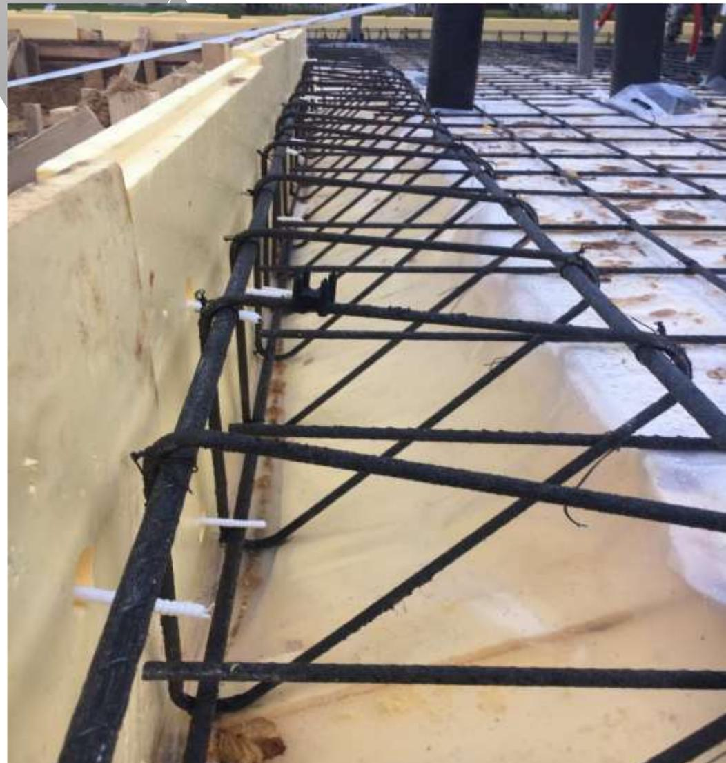
Композитные элементы для каркасов
