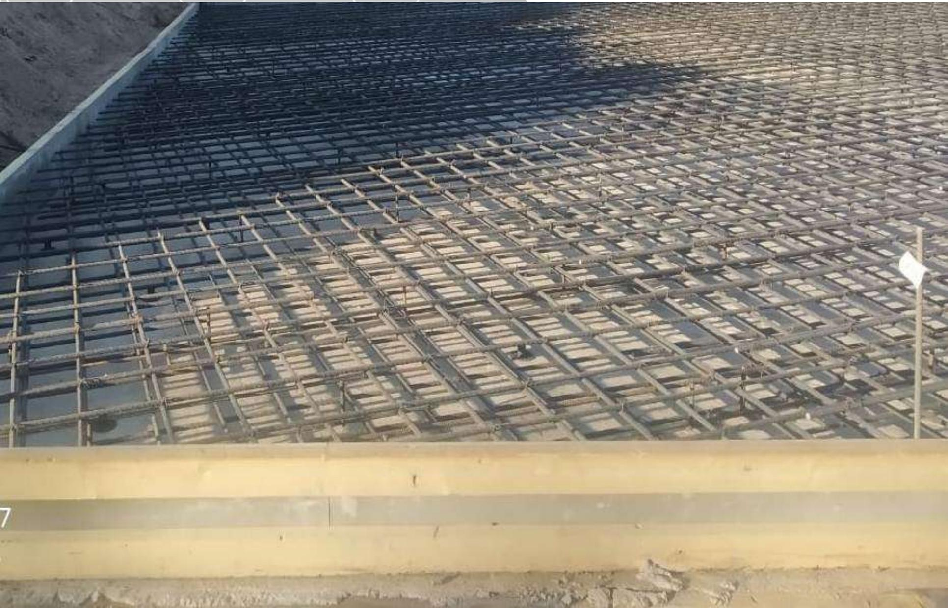
Использование композитной арматуры торговой марки BASIS в строительстве. Цокольный этаж трехэтажного здания
