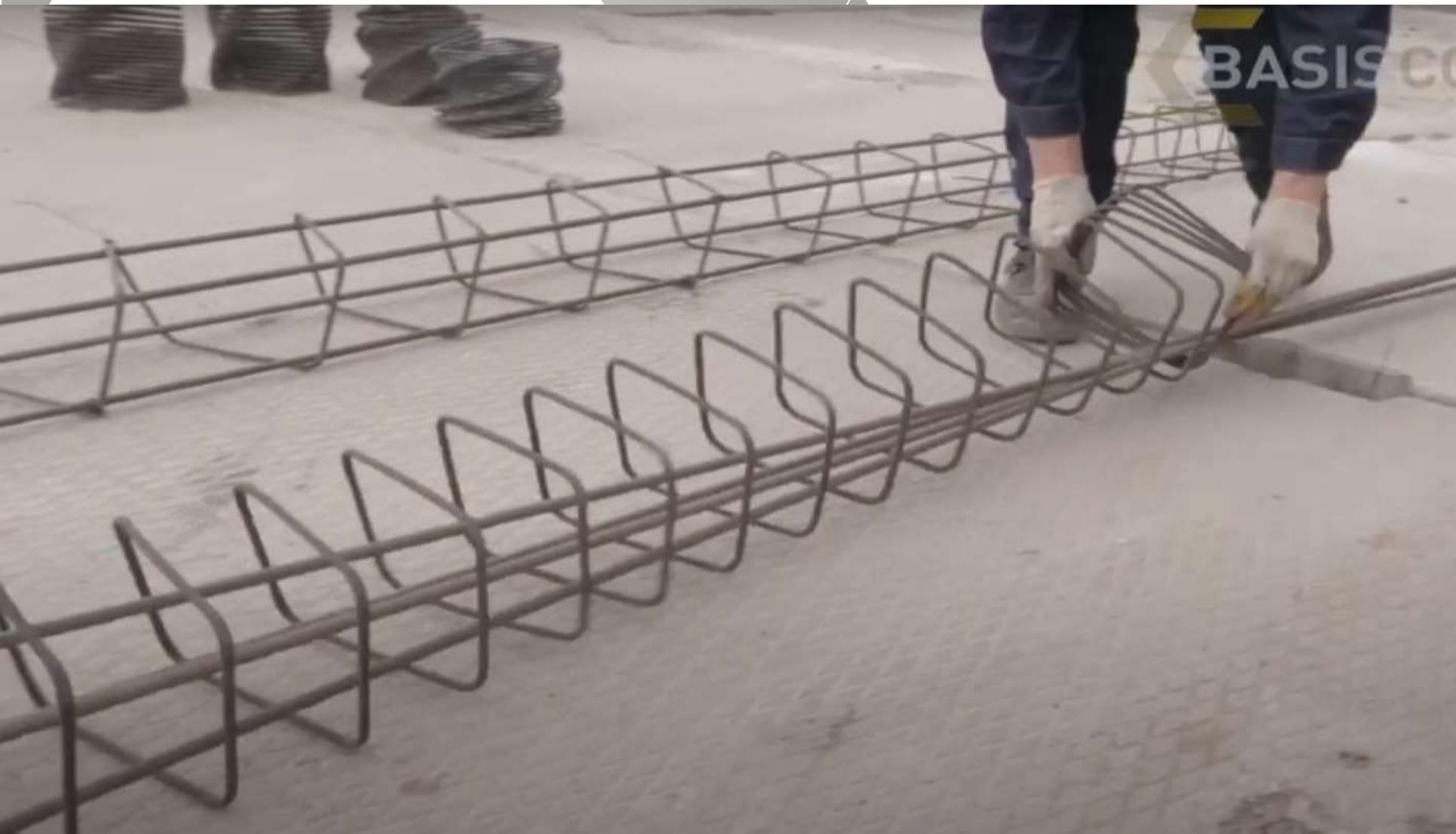
Композитные элементы для каркасов
