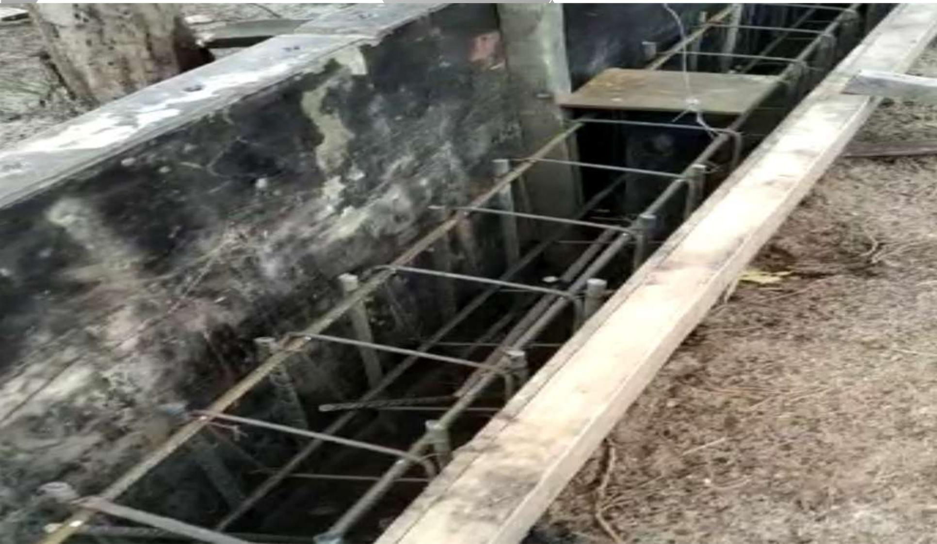
Предварительное напряжение композитной арматуры
