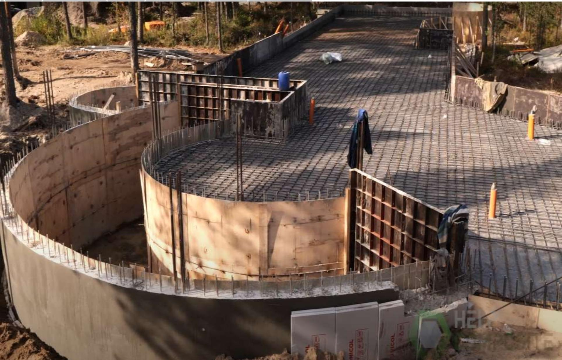
Использование композитной арматуры торговой марки BASIS в строительстве. Перекрытие цокольного этажа. Комбинирование.
