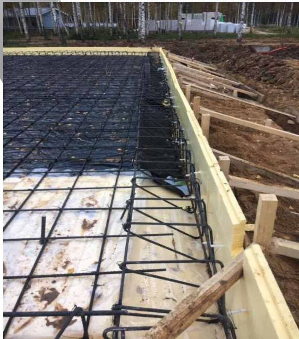
Композитные элементы для каркасов
